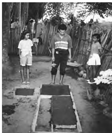
Figura 4: Participación comunitaria en la construcción de tapas de tanques interceptores.
