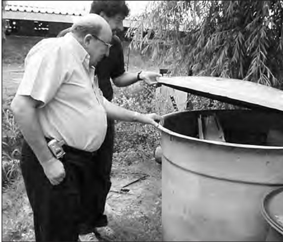
Figura 10: Detalle de tanque interceptor diseñado para implementar el sistema de saneamiento ASAS en el Barrio San Martín. Partido de San Fernando. Provincia de Buenos Aires.
